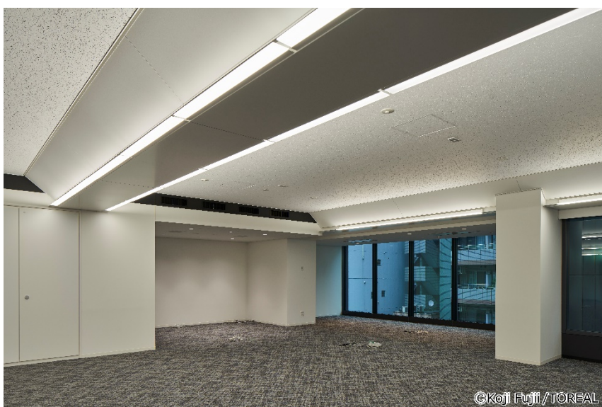
図2 自律式風速一定器具「Air-Soarer」を使用した変風量コアンダ空調システム (新菱神城ビル)
